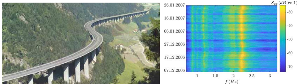
A13 Luegbrücke (Tirol) / Reaktion des Brückendecks über einen Zeitraum von 2 Monaten
